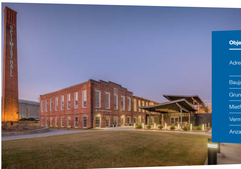
Die ehemalige Textilfabrik Optimist Hall wurde zu einer Büro- und Einzelhandelsimmobilie umgebaut
