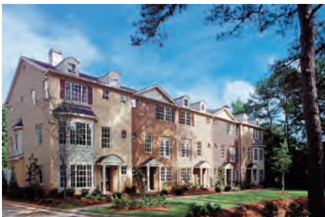
Gepflegte Reihenhäuser umgeben von einem alten Baumbestand
