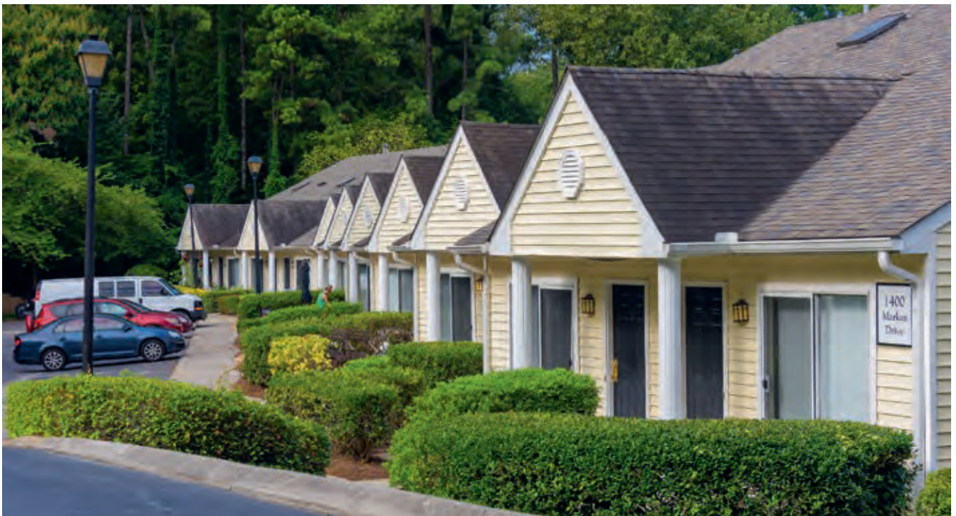
Wohneinheiten mit Garten der ersten Bauphase, fertiggestellt im Jahr 1987
